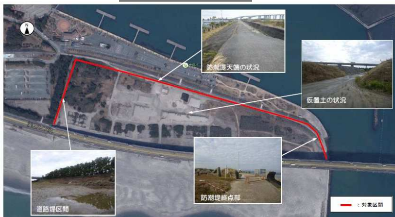
平成26年度〔第26-W2007-01号〕浜名港海岸 防災・安全交付金【高潮対策事業】に伴う堤防（改良）設計業務委託（新居今切口防潮堤）設計概要書
