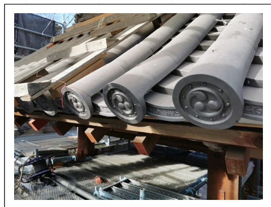
↑葺き替え後の屋根瓦
