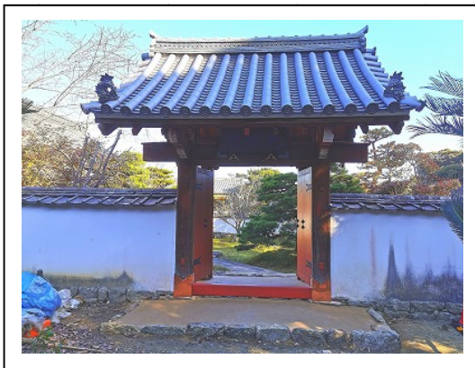
↑解体修理後の中門
