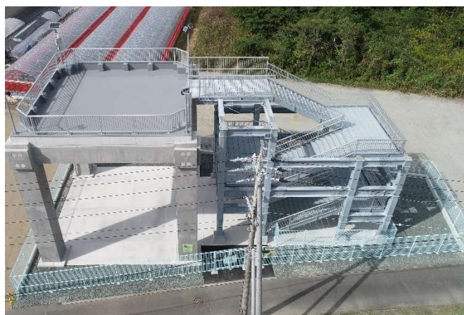
高師山津波避難タワー
