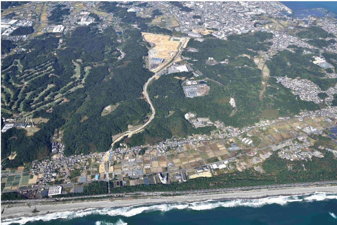
大倉戸 IC から湖西バッテリーパークを結ぶバッテリーロード（令和5年夏頃開通予定）
