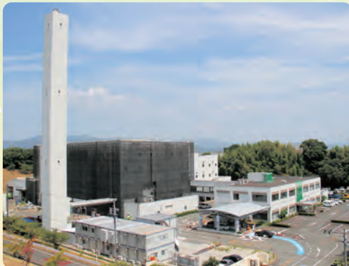
▲湖西市環境センターの煙突
