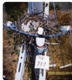
春が近くなると、カラスが産卵のために電柱に巣を作ります。巣の中には針金などの金属も入っていて停電の原因となります。電柱の上にカラスの巣を発見したら、問い合わせ先へ連絡してください。
