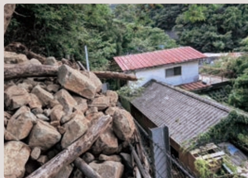
崩壊した土砂を止める！
