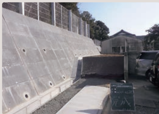
ようへきこう 擁壁工の設置をすることで…
