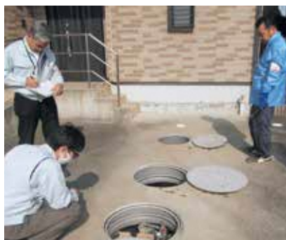
浄化槽パトロールの様子(昨年)
