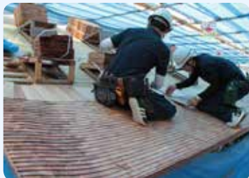
▲こけらぶき屋根づくりの様子。屋根には、皆さんの願いやサインが書かれたこけら板が打たれています。
