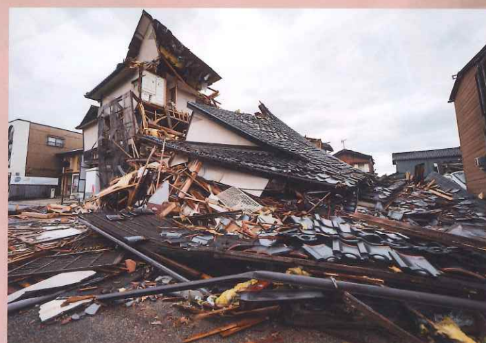
全壊した木造家屋(輪島市)
