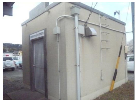
〈写真右：市役所大気測定室〉
