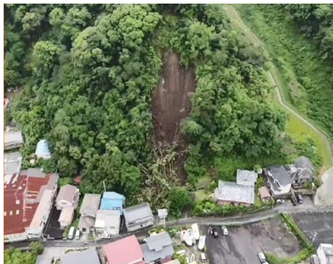
静岡県下田市敷根の土砂災害発生状況
