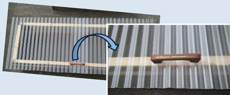
【5】木枠に、波板用座金(※突き抜け防止用)でポリカ波板を固定する。
