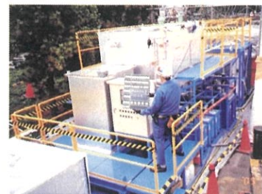
洗浄水の浄化設備
