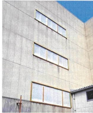
建屋窓の密閉養生
