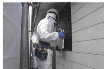
手作業による原形撤去
