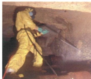
高圧水洗浄(焼却炉内)
