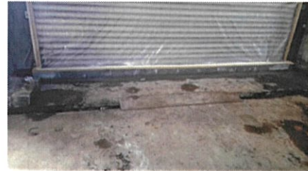
建屋出入口の密閉養生
