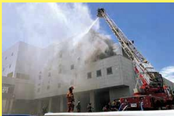
環境センター火災(令和5年5月)
