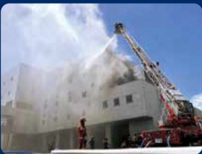
▲Incêndio no Centro de Controle do Meio Ambiente (Kankyo Center)(Em maio de 2023(R5))
