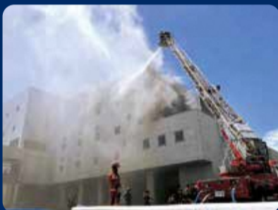
▲Incendio en el centro de control del medio ambiente (mayo del 2023)
