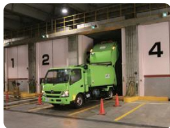
プラットフォーム 計量されたごみは収集車でプラットフォームにある投入扉からごみピットへ投入されます。収集車は一日約50台やってきます。
