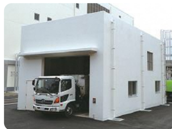
汚泥受入棟 市内の下水処理施設で発生した汚泥を受け入れ、ごみと一緒に焼却処理をしています。
