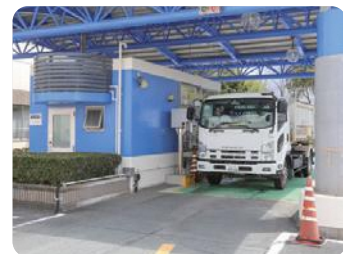
ごみ計量機 市内から収集されてきたごみは、重さを量り、コンピュータで集計・記録されます。
