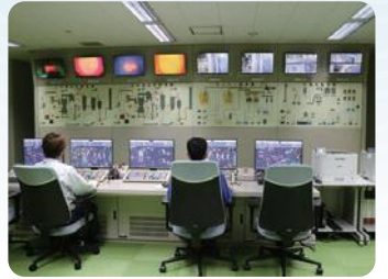
中央制御室 焼却炉や主要設備の運転はコンピュータにより自動化されており、運転状況は集中的に監視、制御されています。
