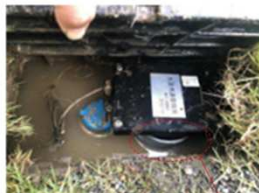
■柵内の設置位置改善
