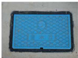
■水道柵、水道蓋の交換
