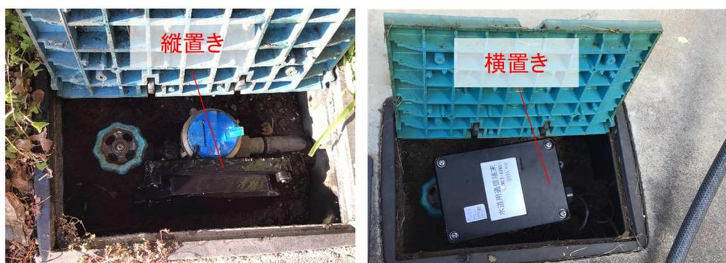
図 2-7 地下式通信端末設置例（縦置き・横置きの例）
