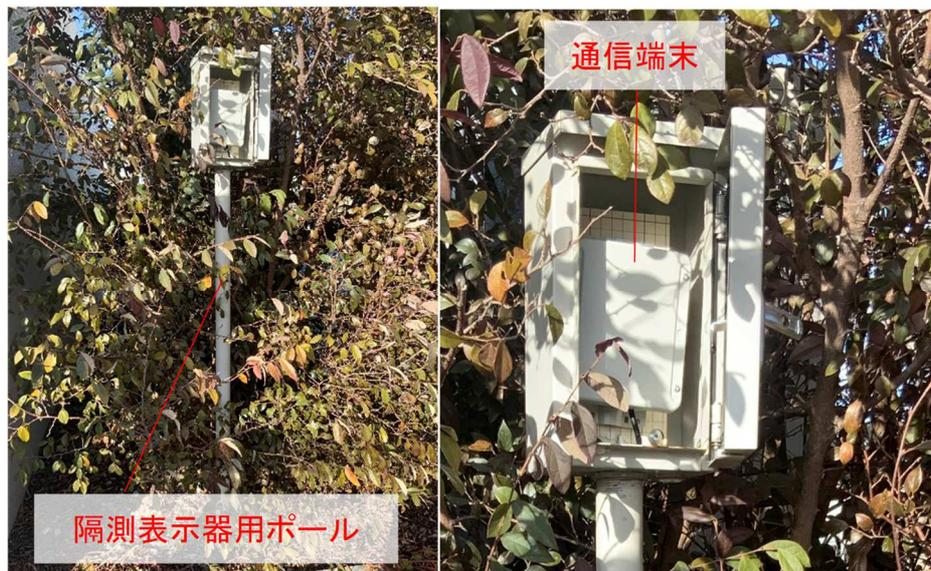
図 2-6 地上式端末設置例
