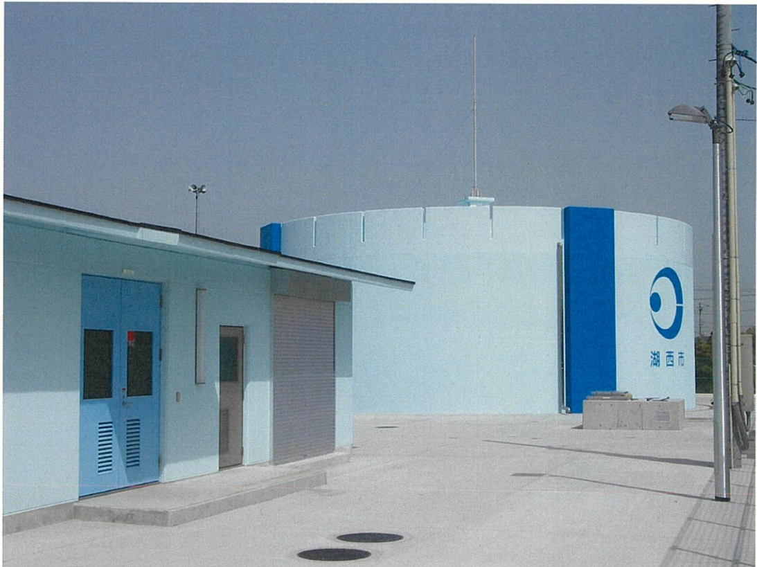
新所原南配水場
