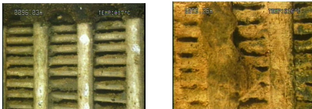
図 4.3.9 井戸ストレーナーの状況 (左図：健全なストレーナー 右図：錆こぶ等により目詰まりしたストレーナー)
