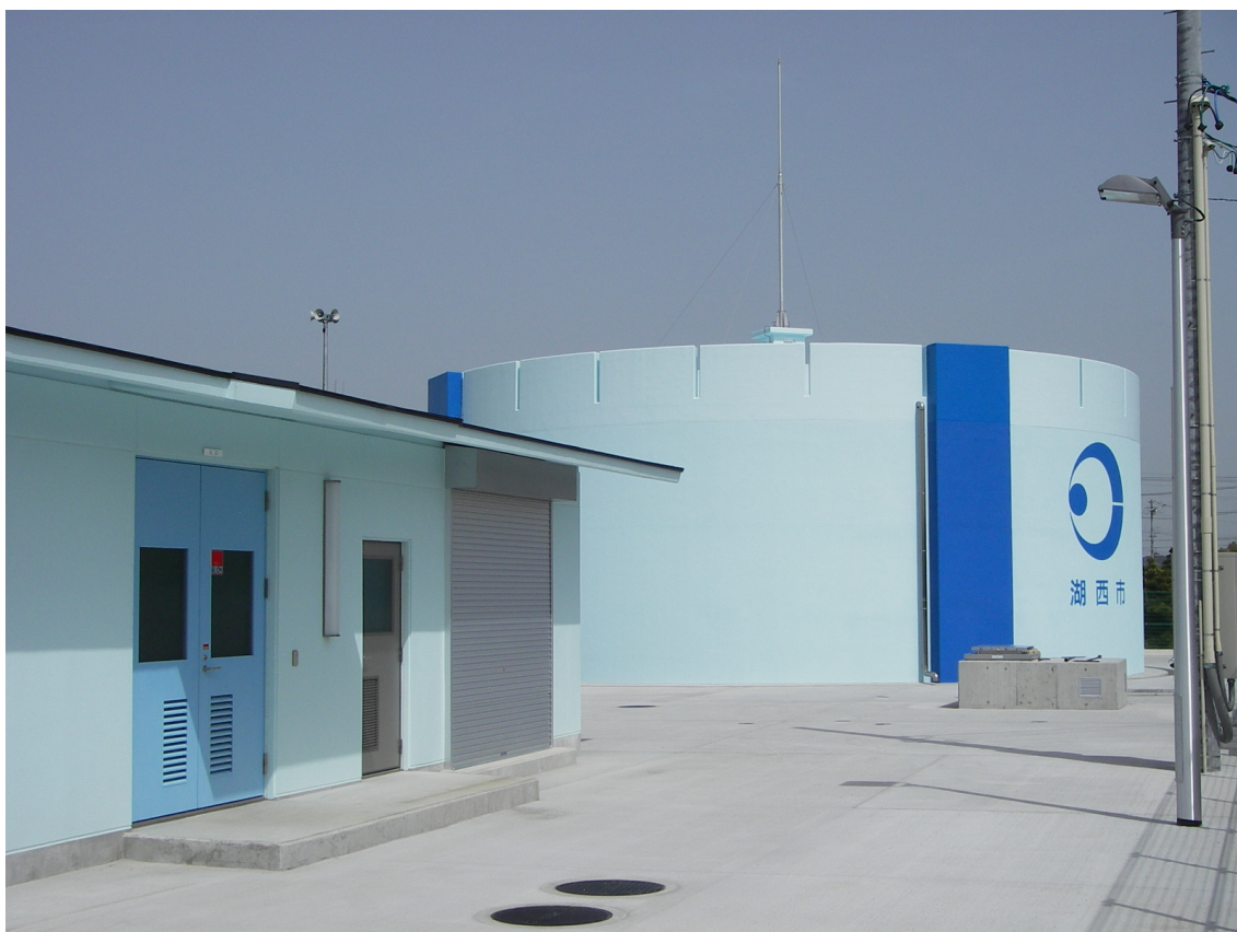
新所原南配水場
