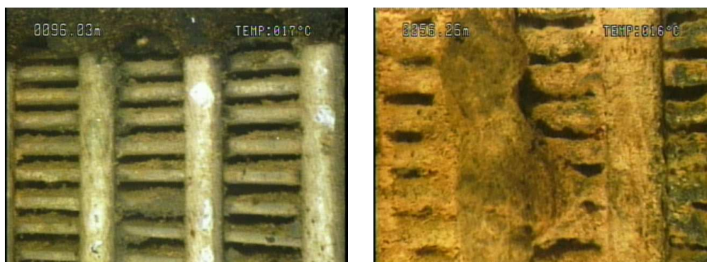
図 4.3.8 井戸ストレーナーの状況
