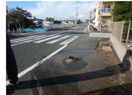
➤ 老朽化による漏水状況
