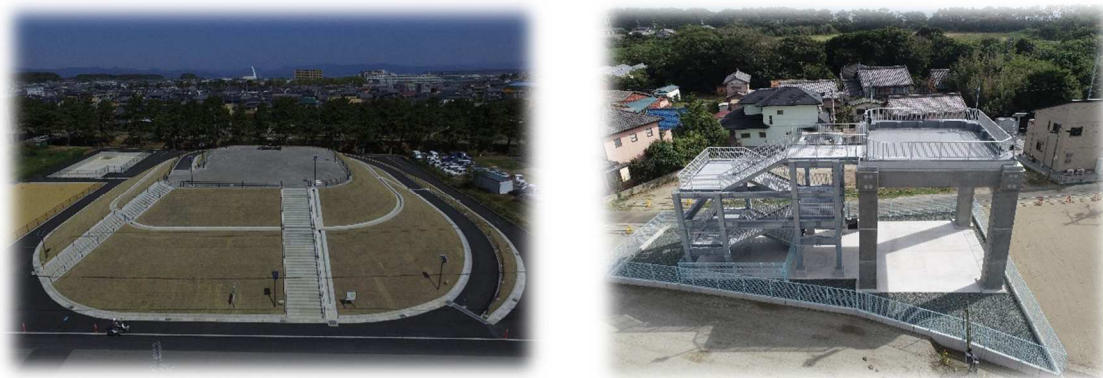
図 5-4 津波避難施設（命山、津波避難タワー）
