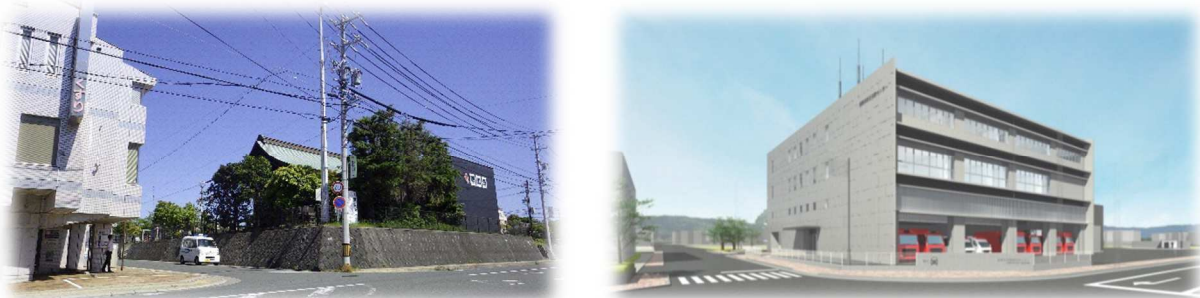
図 5-5 防災行政無線、消防防災センター（令和8年度稼働予定）
