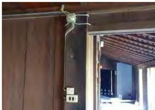
図4-16 老朽化した電気設備
