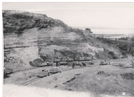
1-43 埋立用土砂の掘削風景
