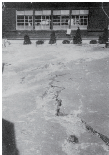
8-2 昭和東南海地震によりひび割れた 入出小学校の校庭
