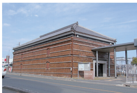
2-24 旧宮崎製糸鷺津工場繭倉庫
