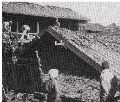
8-3 昭和東南海地震により半壊した建物
