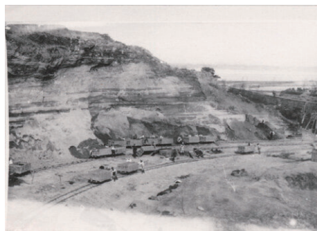
1-43 埋立用土砂の掘削風景
