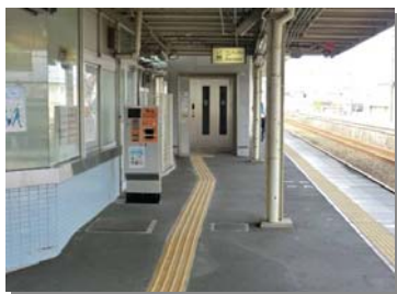
■エレベーター設置事例(鷺津駅)
