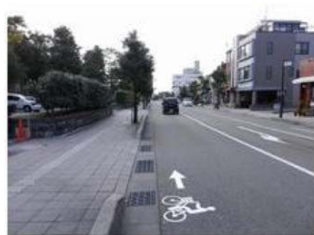
◎ピクトグラムを設置した事例
