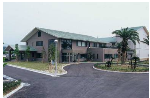
湖西浄化センター
