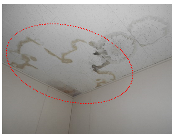
⑤排煙窓・トップライト壁の結露、雨漏りによる塗装劣化、天井のシミ
