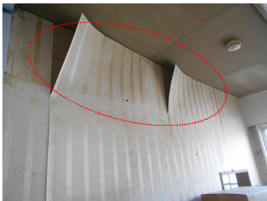
④壁のひび割れ、剥がれ
