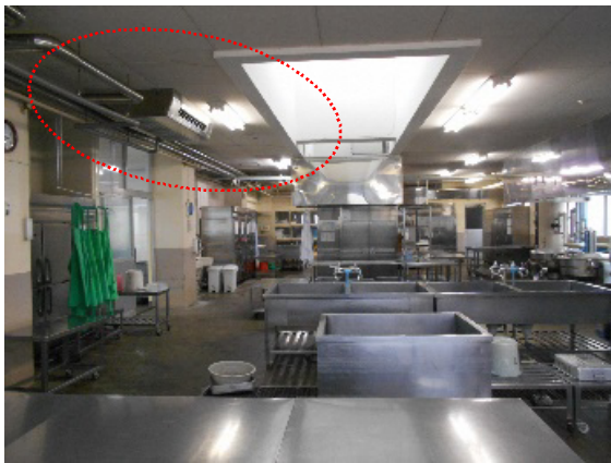
④空調施工後の露出配管
