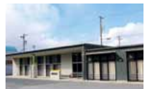
▲耐震化のため平成20年度に新築された南上の原集会所
