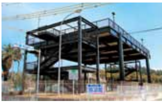
▲防災・減災対策として設置された津波避難デッキ
