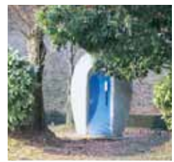
▲湖西運動公園野球場バックネット裏トイレ
