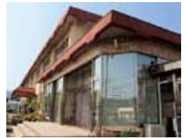
▲ 北部多目的センター
