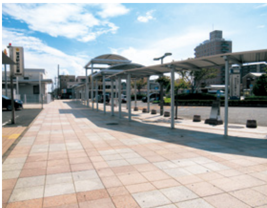
▲現在の鷲津駅前広場シェルターの様子
