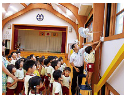
▲9月に整備された白須賀幼稚園のエアコン
