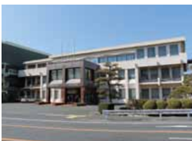
解体が予定されている新居庁舎
