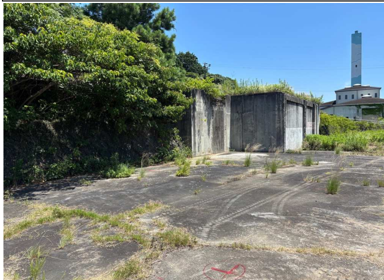
B仮設ステージ 南西角
