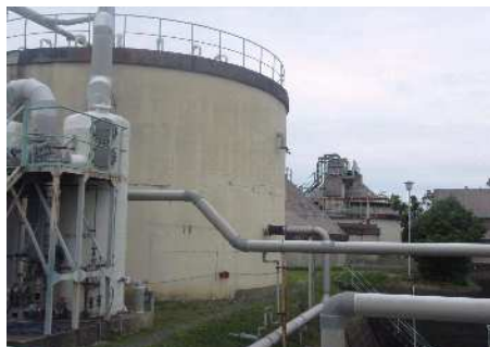
老朽化が著しかった処理水槽
