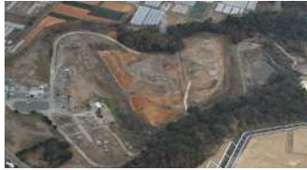
<笠子廃棄物処分場の全景>
