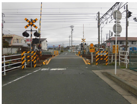
鷲津踏切の改良
