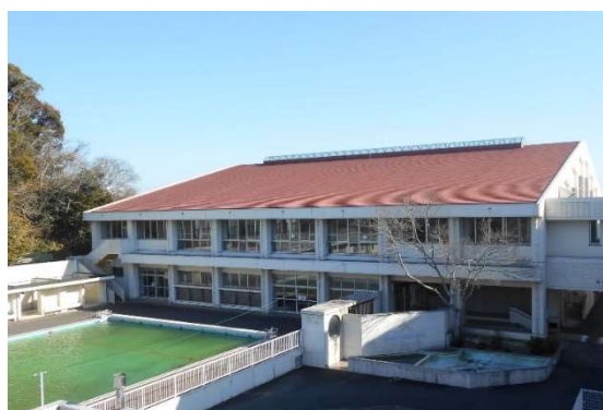
新居小学校体育館屋上外壁改修事業
