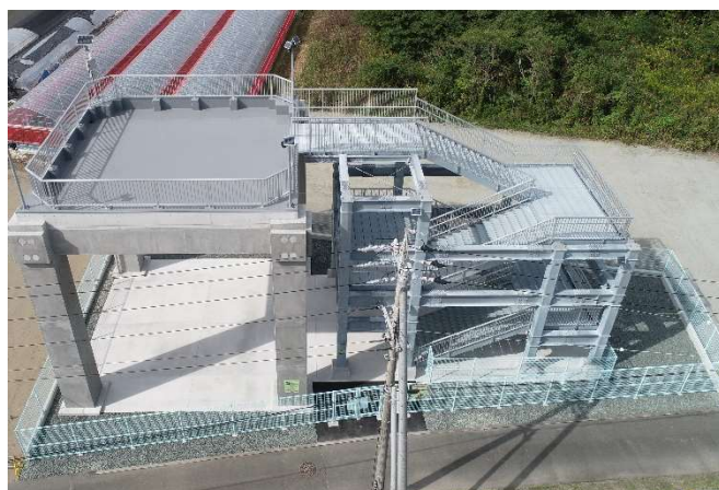
高師山津波避難タワー
