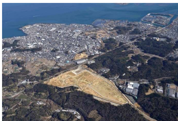
浜名湖西岸土地区画整理事業・大倉戸茶屋松線整備事業 (令和4年1月時点)
