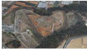
〈笠子廃棄物処分場の全景〉
