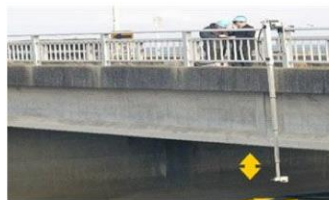
懸垂型を用いた点検
