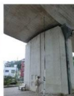
高所型を用いた点検
