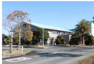
湖西市浄化センター
