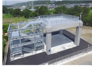
日ヶ崎地区津波避難タワー
