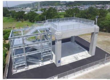
日ヶ崎地区津波避難タワー
